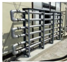
二重管式熱交換器
