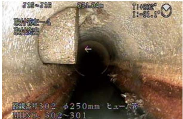
▲ 下水道施設が原因で起きた道路陥没と、下水道本管に突出した取付管
