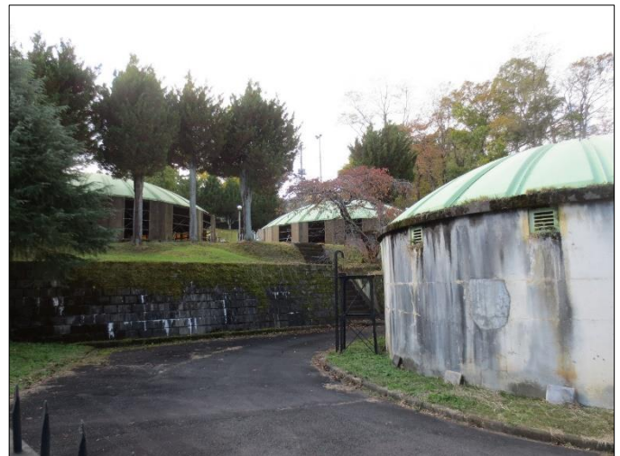
伊香保温泉物間沢水質管理センターの散水ろ床施設
