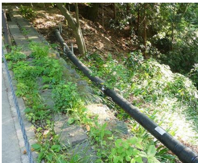
登山道沿いの露出排水管
