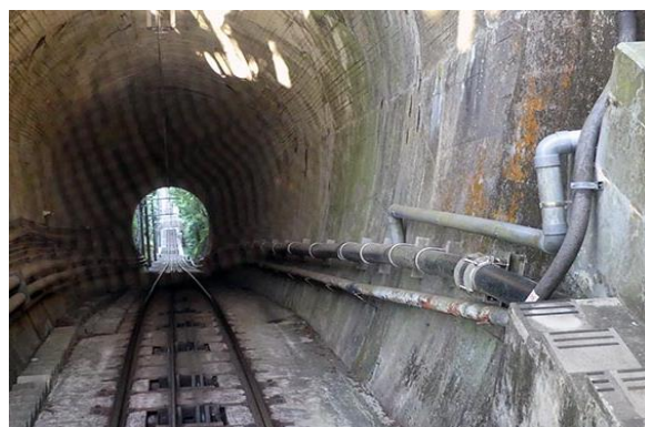
トンネル内の公共下水道管(右壁上部)
