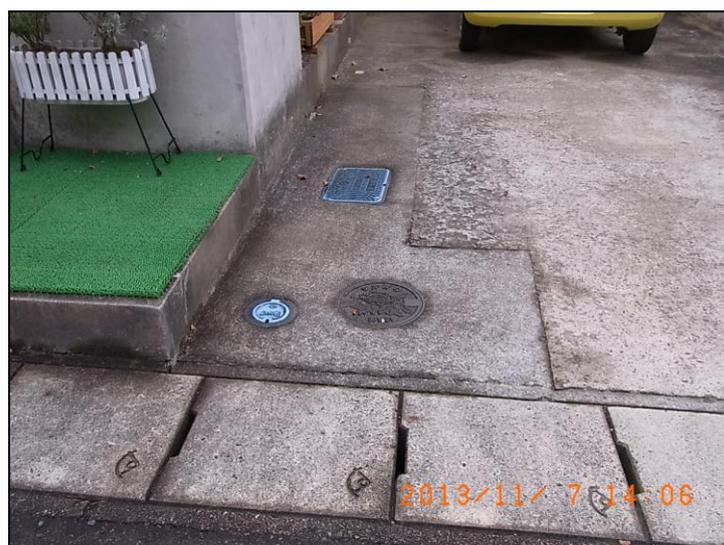
同じく水道の止水栓とならんだ宅内の汚水ますを写しています。
