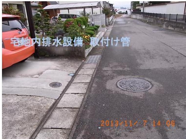
このマンホールもよく見ていただきますと、道路上の大きなものと敷地内の小さなものがあるのがわかります。各家庭内の排水設備から公共下水道に繋がる箇所を示していきまして、それを繋ぐのが取付管、こうした排水設備、取付管の部分が下水道では意外と大事であるということで、昨年1月当方の水倶楽部でも「排水設備と取付管の今日的役割」の研究集会を開催したところです。雨水は側溝へ、汚水を確実に下水道にというところが分流式下水道の基本になるところです。
