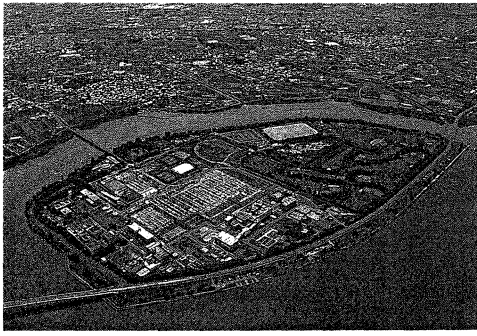
▲湖南中部浄化センター
