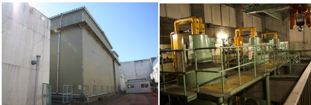
写真 10 外置きの熱交換器と低温加圧熱処理反応缶 2011.2.16
