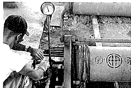
圧力管内圧検査
