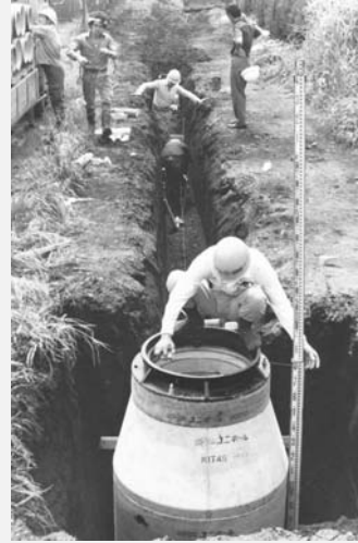
写真 - 4 1号基設置のようす（相模原市横山台）
