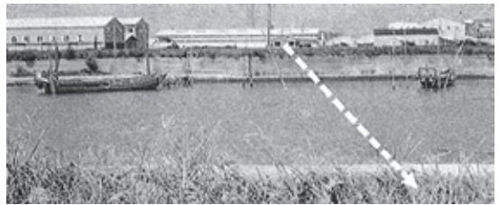
写真-7 河川横断箇所
