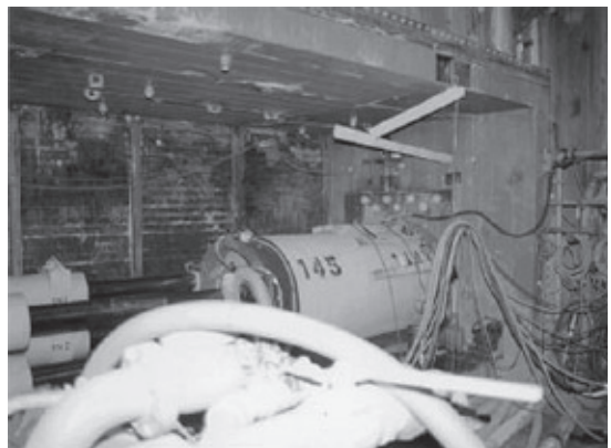
写真-6 ステーション内推進状況
