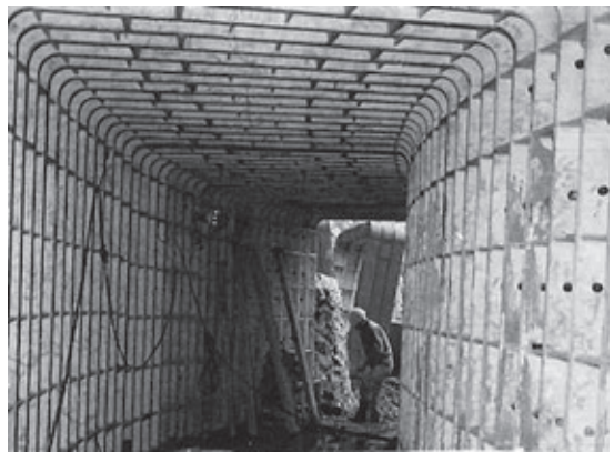
写真-3 混合推進（曲線部）
