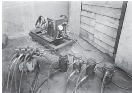
て作られています。従って、これらを並列に4台並べた時に30トン×4=120トンの推力を出させるのは至難の業です。と言うのは、これらの各ジャッキが全部同一の推力がかかったタイミングの時だけ120トンの合算推力を期待できますが、少しでもおくれたジャッキは、実際には殆んど無負荷で推力発揮の役目を果たしません。このことが、初めの頃の推進工事の推進延長の限界をもたらしていました。そして、2台の60トンまでは比較的容易に合算推力が得られることと、当時すでに表面の摩擦低効力を測っており、大体1トン/m<sup>2</sup>ということから、φ1,000mmのヒューム管で20mが一つの限界だと言われていました。
