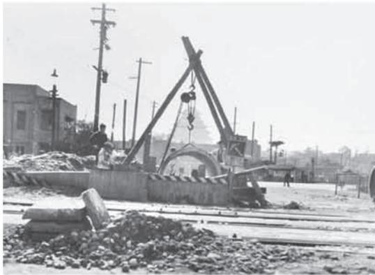
12年後の昭和40年に熊本市内で施工されました。その工事は「V号幹線下水道築造工事」といわれる工事で、目的は電話地下ケーブルのマンホール基礎を避けるためにカーブ延長25mの間で半径約80mのカーブ推進が行われました。この時は、各継輪のプレート厚さに左右36mmの差をつけて発進坑からカーブに入る方法でしたが見事に成功しています。現在のカーブ推進の理論的基礎と可能性の裏付けは、実に20年前に実証されていたわけです。
