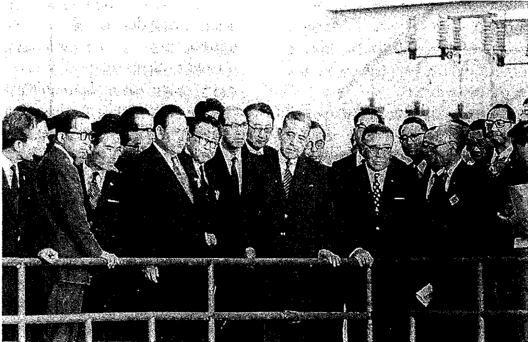
猪名川流域下水道原田処理場を視察する佐藤栄作総理（中央）、右は根本龍太郎建設大臣、左は久保尅建設省下水道課長（いずれも当時）（昭和45年9月9日）
