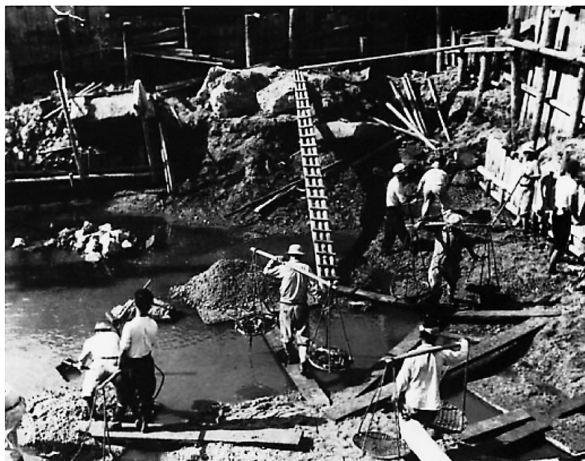
中部処理場建設現場風景
