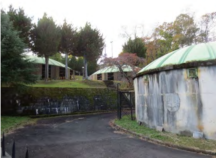
写真-4 奥は初沈、手前に散水ろ床が 2 槽
