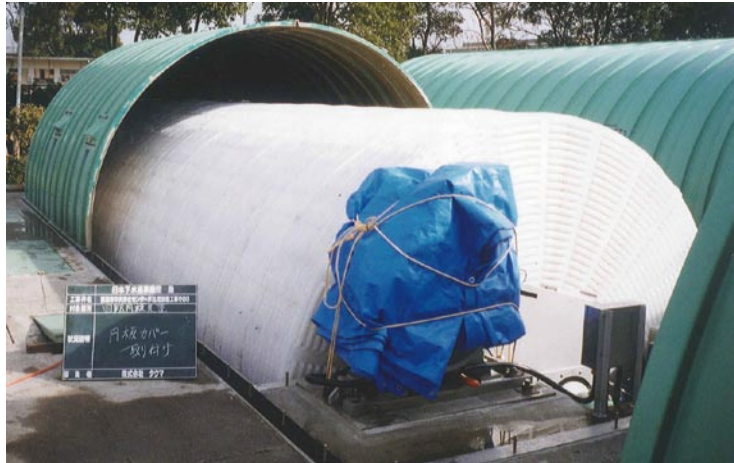
回転円板取替え工事（回転軸折損事故）
