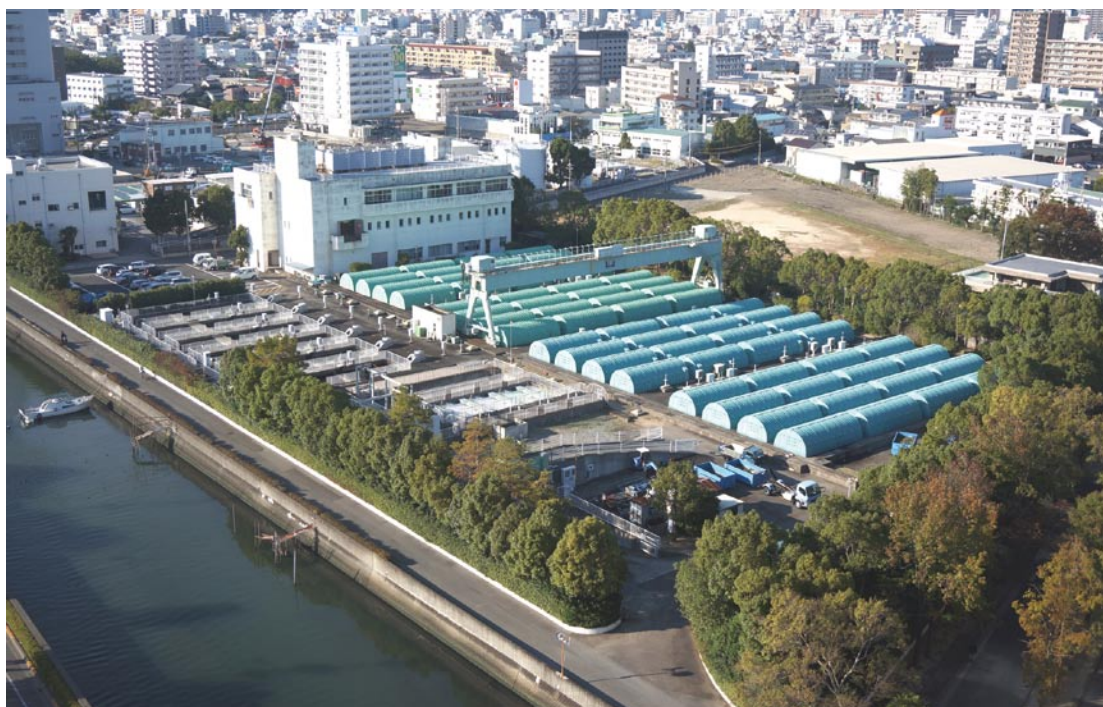
中央浄化センター全景。手前カマボコ状の施設が回転円板接触槽
