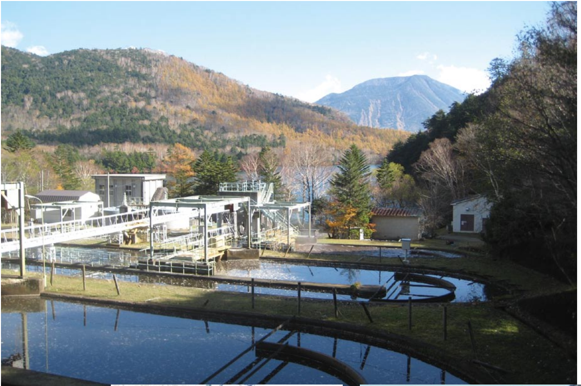
上：湯元水処理センターオキシレーションディッチ施設、下左：ばっ気ローター運転状況、下右：コカナダモ除去状況
