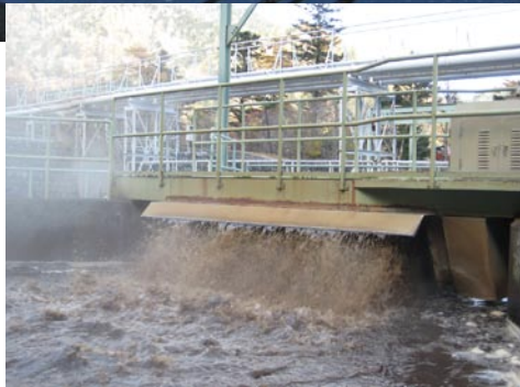
上：湯元水処理センターオキシレーションディッチ施設、下左：ばっ気ローター運転状況、下右：コカナダモ除去状況
