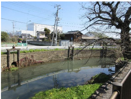
写真-5 取水用の3つの樋管とゲート
