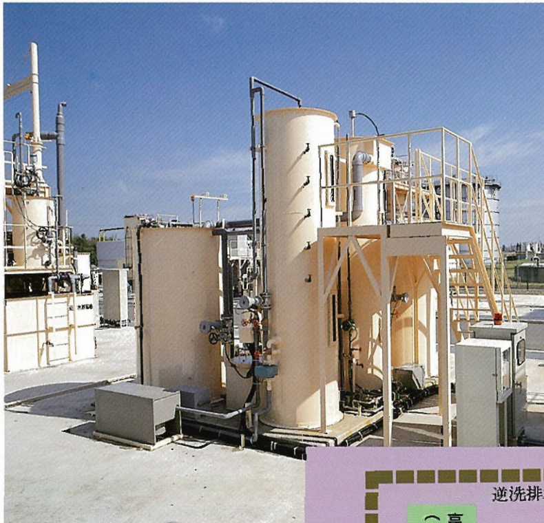
ハイレート・セパレータと 固定床バイオリアクターパイロットプラント (設置場所：バイオフィーカスヤード 茨城県土浦市内)
