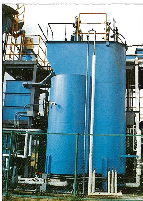
写真の槽の右側部分が生物反応槽、左側部分の上部が傾斜板、下部が沈澱槽
