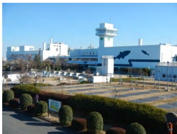
写真-4 多摩川上流水再生センター
