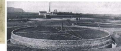
微生物を使った処理法(散水ろ床法)
