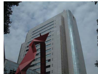
墨田区役所 1000トン
