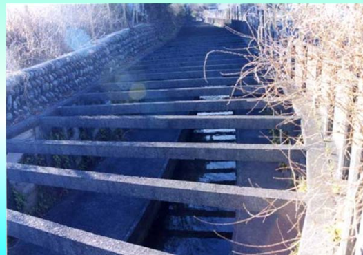
小金井市内 写真提供:東京都河川部
