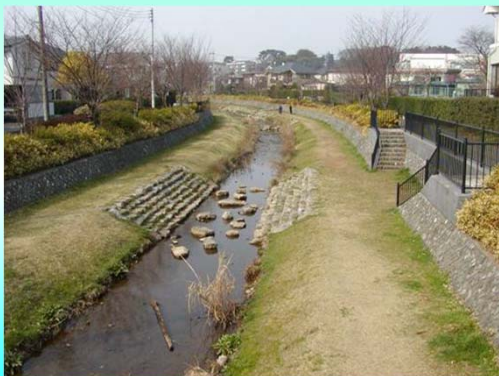
小金井市内 写真提供:東京都河川部
