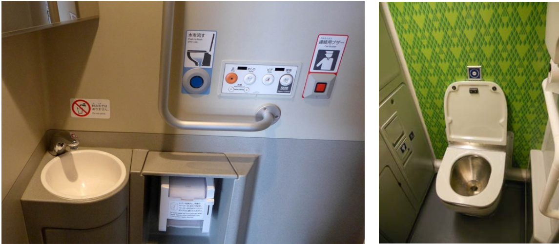
写真5 ベンドリーノS220の真空式トイレと洗面所〈2017.3.29〉
