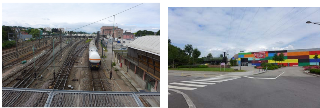
写真5 ミュールーズ駅から鉄道博物館へ向かう橋梁から見たミュールーズ駅構内とフランス国立鉄道博物館 2013.7.4 亀田泰武氏提供
