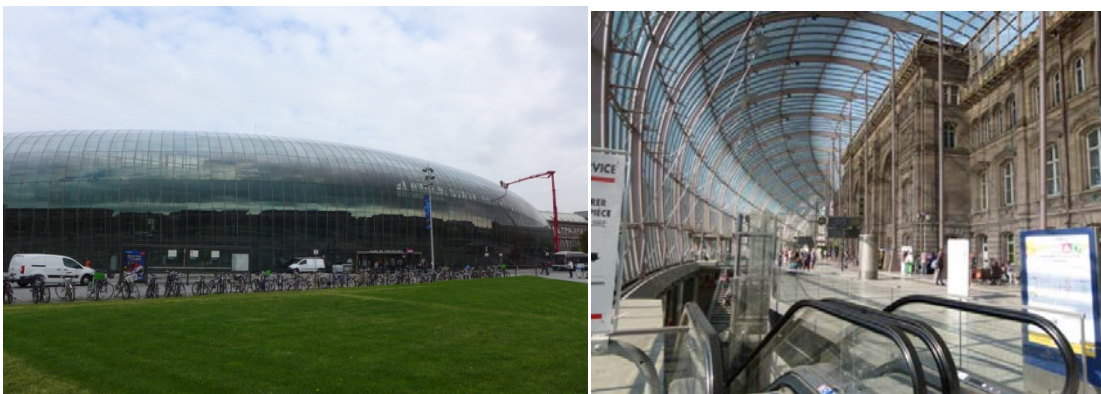
写真16 ガラスで覆われたフランス国鉄ストラスブール駅とその中の駅舎 2013.7.6 亀田泰武氏提供
