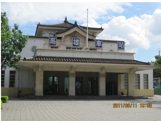
写真一12 保存中の旧高雄駅舎。現在、高雄駅は工事のため仮設駅舎を使用していますが 高速鉄道が開通すればこの保存中の駅舎を使用するそうです。
