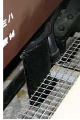
写真 10b. 交通科学館マロネフ 59 1 洗面流し管 07.2.14
