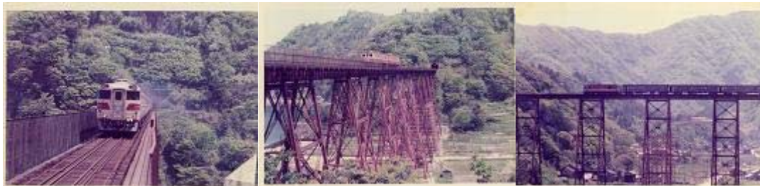
写真 8a. 餘部鉄橋を行く下り
