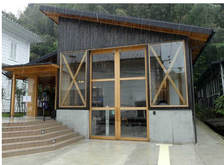
写真1. 高知県佐田町の480型481号二等木製客車の保存場所
