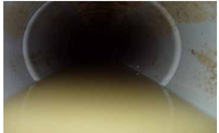
マンホール付近
