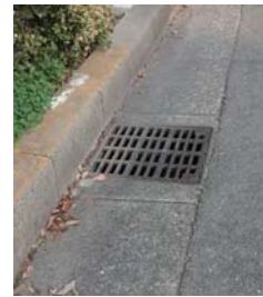
④道路排水雨水ます(水たまり有り)
