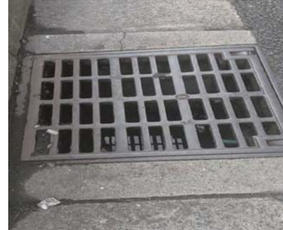
④道路排水雨水ます(水たまり有り)
