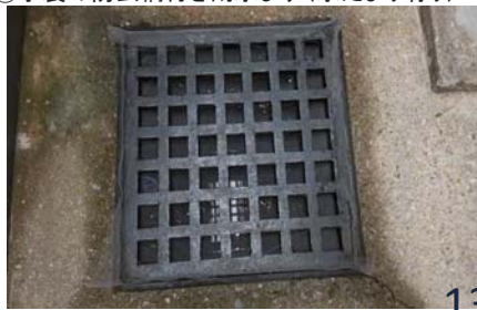
④手製の防虫網付き雨水ます(水たまり有り)
