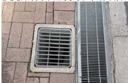
③宅地内雨水ます(土砂少なし・水たまり有り)
