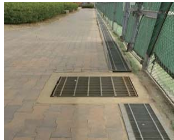
④手製の防虫網付き雨水ます(水たまり有り)
