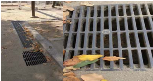
③宅地内雨水ます(土砂少なし・水たまり有り)
