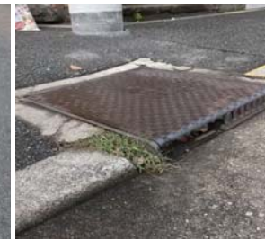
④道路排水雨水ます(水たまり有り)
