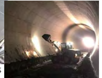
堆積土砂の除去工事
