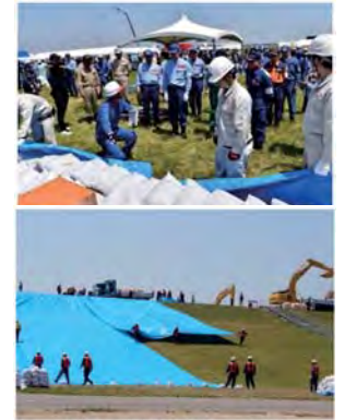
水防団による水防工法(裏シート張り工) 利根川水系 水防演習 H29年
