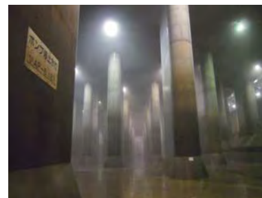
調圧水槽(長177m 内幅71m 内高18m)
