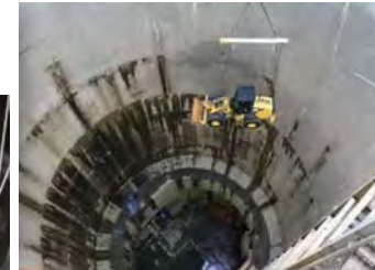
堆積土砂の除去工事
