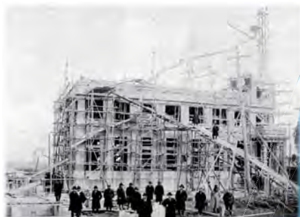
熱田抽水場 建設風景
