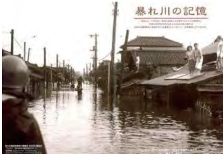
1958(昭和33)年「狩野川台風」被害状況 (国土交通省による記録映像より)
