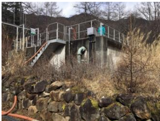
写真 2 平成 13 年着手した流量調整槽
