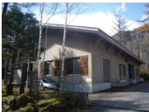
写真 1 海拔 1500m に位置する管理棟
