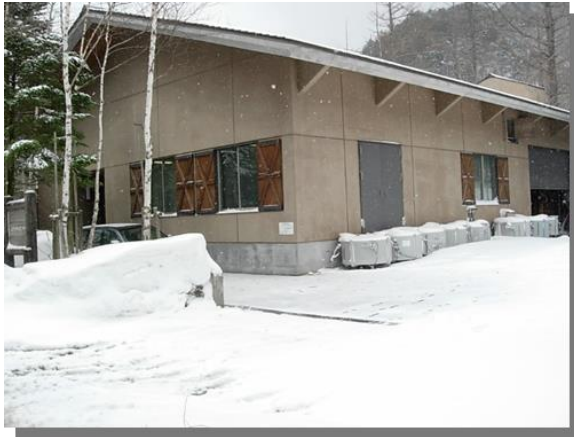
写真3 4月からの運転開始前の処理場
