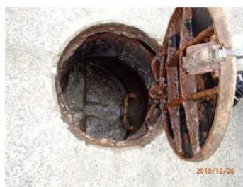
高尾山駅上流の蓋の腐食
