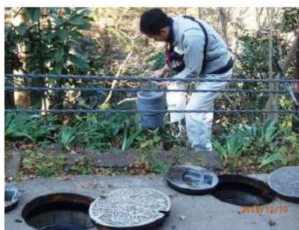
山頂トイレからの接続部分 16
