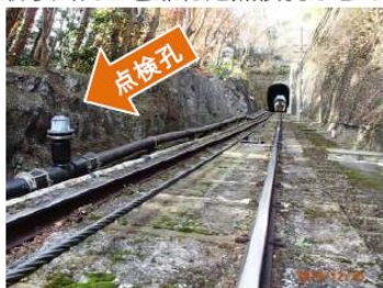
交換した密封点検孔（空気吸入はできない）
