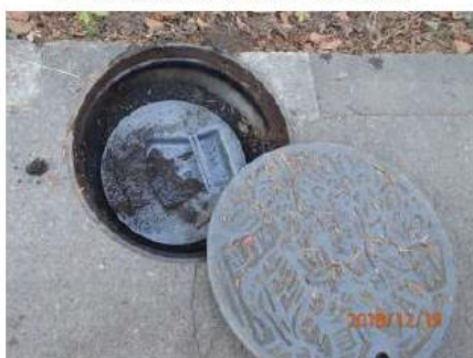
点検孔 2重蓋 滑り止め塗装
