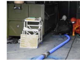
汚水の抜き取り作業
