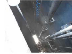
槽内洗浄・点検
