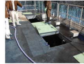
回分槽内洗浄・点検作業
