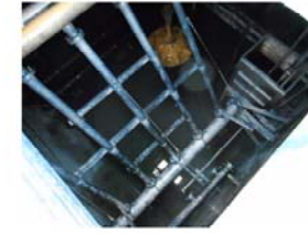
槽内洗浄・点検
