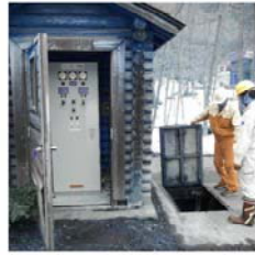
マンホールポンプ場の点検
