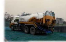
麓の波田浄化センターから大型特殊車両に活性汚泥を積み込む作業
