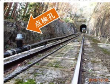
交換した密封点検孔（空気吸入はできない）
