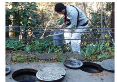
山頂トイレからの接続部分
