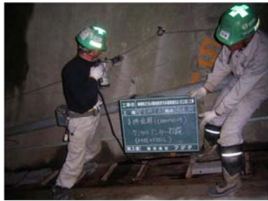
ケミカルアンカー打設
