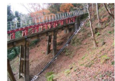
傾斜地の布設状況
