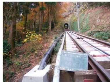
ケーブルカー最大斜度(31度18分)箇所
