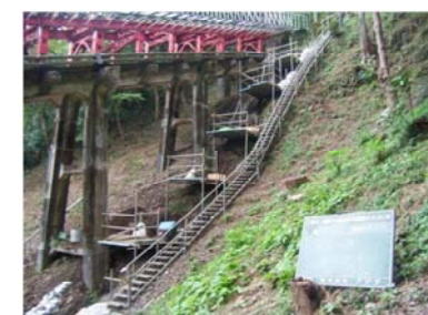
足場設置完了状況
