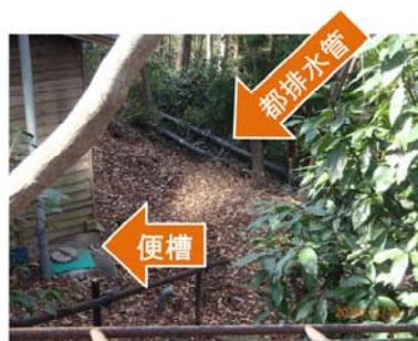
茶屋の裏を通る排水設備管
