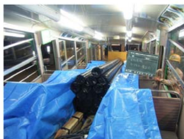
ケーブルカー内の資材積み込み状況
