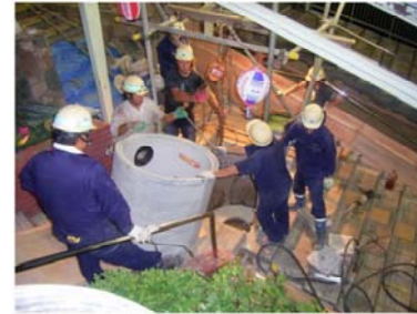
マンホール築造 人力運搬
