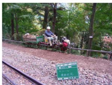
仮設運搬用モノレール 21
