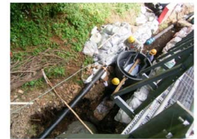
減勢ユニット 設置
