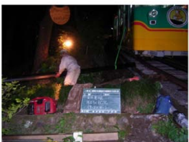
ケーブルカー（途中停車）からの荷卸し
