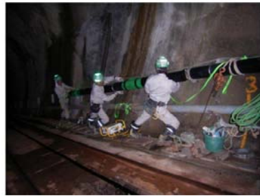
ポリエチレン管 管据え付け
