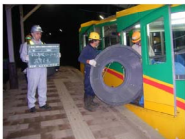
ケーブルカーへの資材積み込み
