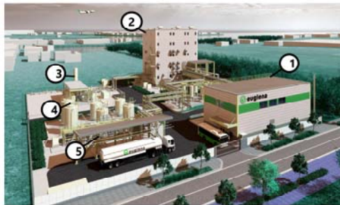
①事務棟 ②反応装置棟 ③用役設備 ④貯蔵タンク ⑤出荷場
