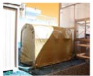
メタン一次貯蔵槽 (ガスホルダー) メタン濃度90%以上 例)CH 4 :CO 2 =95:5
