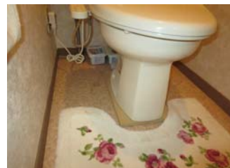
可哀想なりフォーム事例 便器の下に板を入れ、嵩上げ
