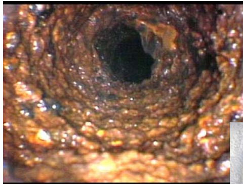
管内部の全面腐食
