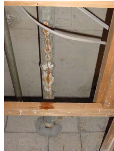
電縫部の溝状腐食例
