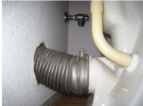
便器を交換したら排水管を逆勾配にされてしまった (有)マンションライフパートナーズ 25
