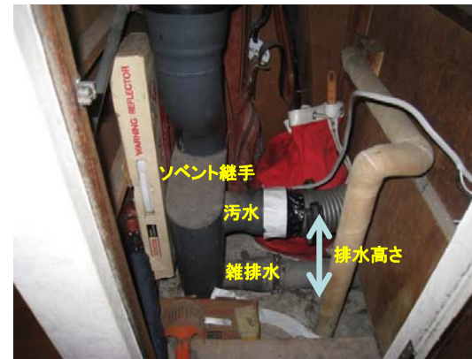
ソベント継手 汚水雑排水二段口継手の限界
