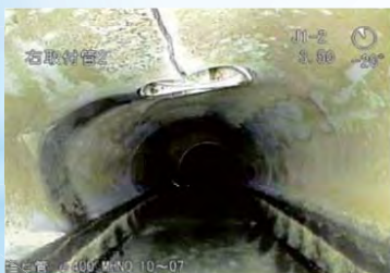
下水管のたわみとクラック
