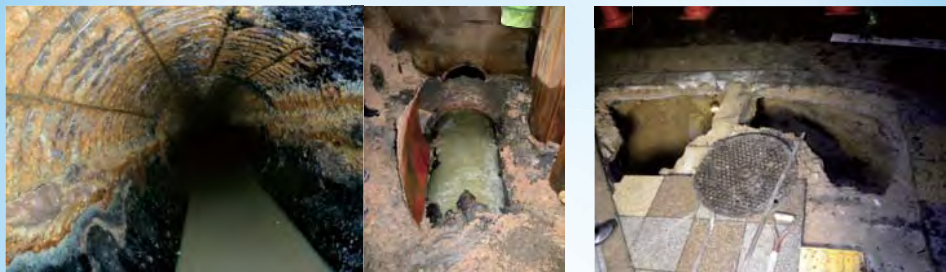
下水管の腐食
