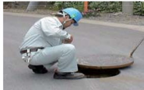
管口テレビカメラ調査
