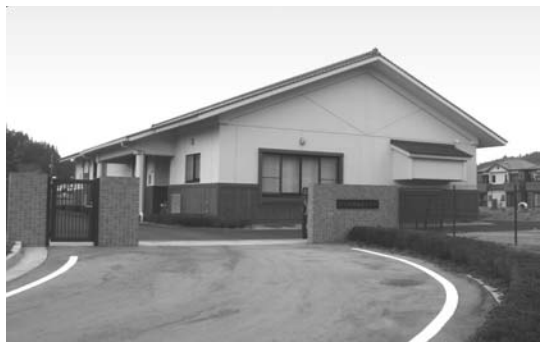
南小国町みなみ浄化センター [645m 3 /日]
