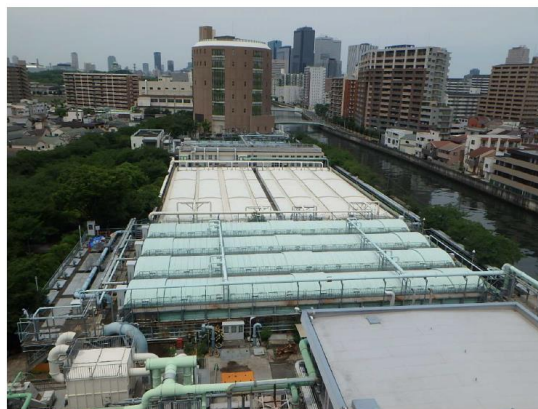
中浜下水処理場（東池）（改築前）
