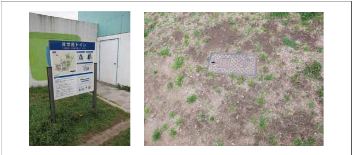
写真－３ 駒澤オリンピック公園内の非常用トイレ
