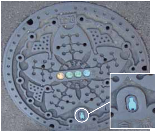
写真-1 トイレの設置ができるマンホールの指定
