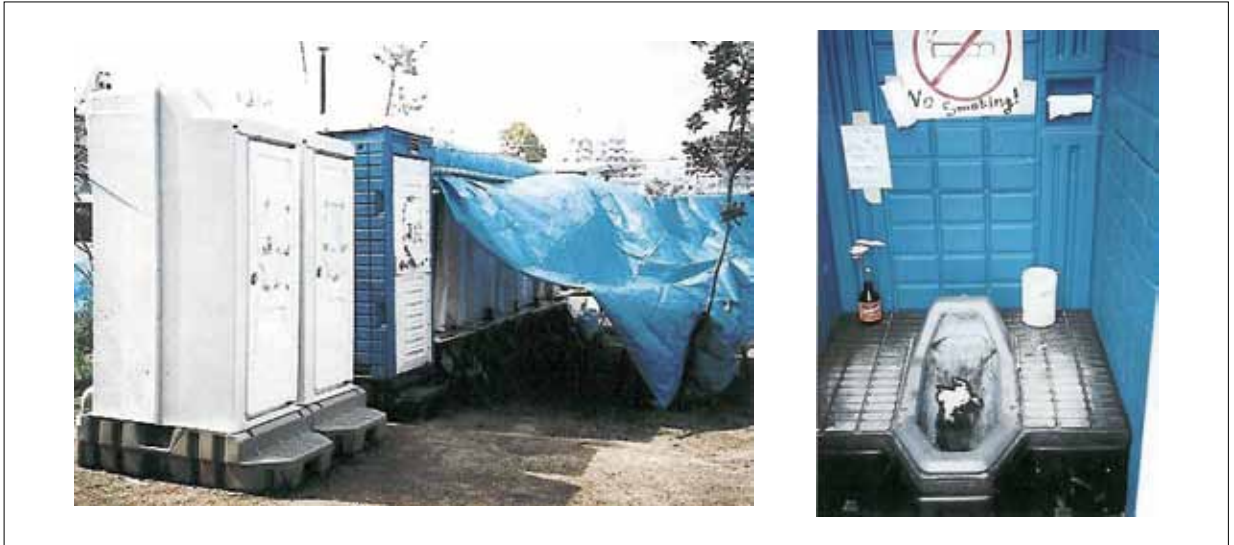
写真－２ 避難所の仮設トイレ（タンク（貯め切り）式）（H7阪神・淡路大震災）
