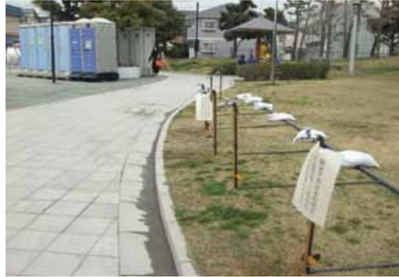
写真-14 液状化により噴出した泥の処理
