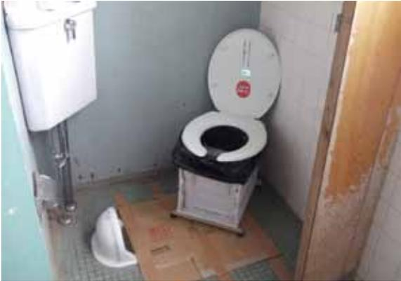
写真-7 和式トイレの上に設置した洋式の簡易トイレ
