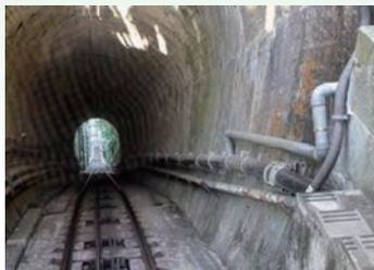
高尾山のケーブルカートンネル内に取り付けられた下水道管
