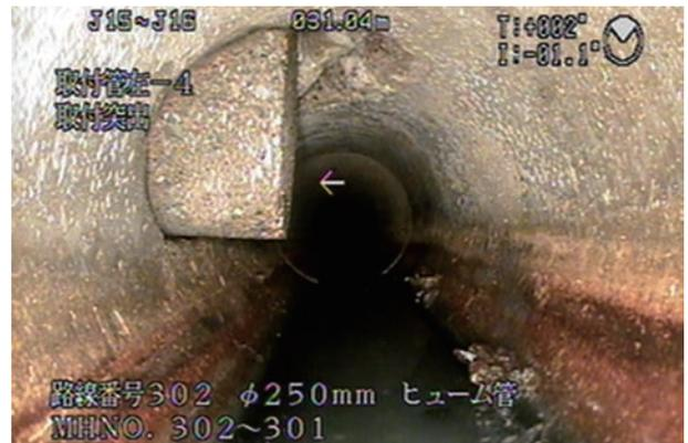
▲ 下水道施設が原因で起こった道路陥没と、下水道本管に突出した取付管
